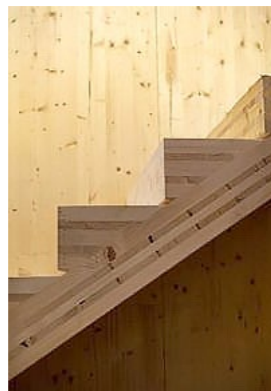
Елемент конструкції сходів з масиву дерева. Фото CLT Rezult
