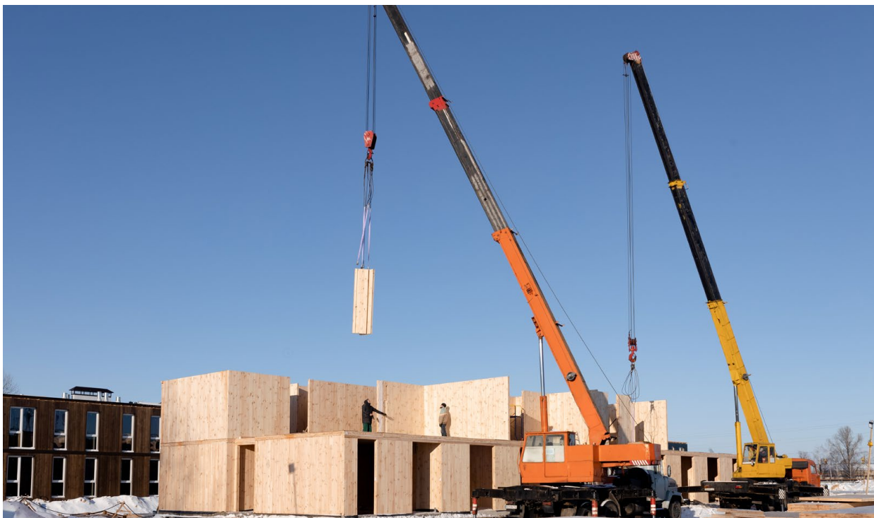
Будівництво будинків з використанням поперечно клеєної деревини (cross laminated timber) у Чернігові для мешканців, які втратили житло внаслідок російської агресії, 2023 рік. Першоджерело контенту - компанія CLT Rezult ( https://clt-rezult.com/ )
